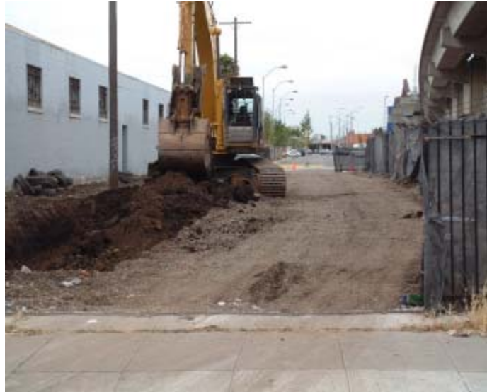
Ejemplo de cómo opera una retroexcavadora en terreno
