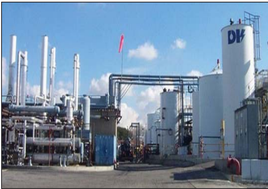
Instalación de DeMenno-Kerdoon
